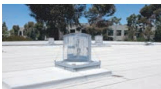
Solatube SkyVault z zbiralnikom in ojačevalnikom svetlobe
