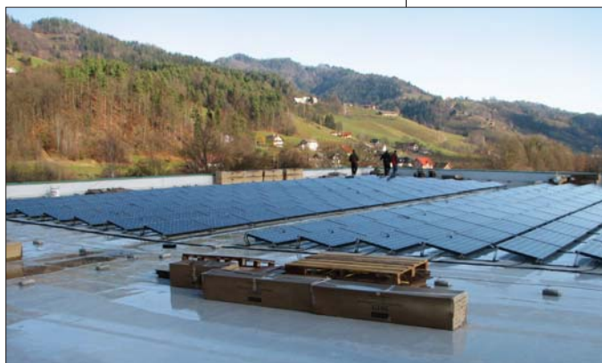
Sončna elektrarna v fazi gradnje trgovskega centra
